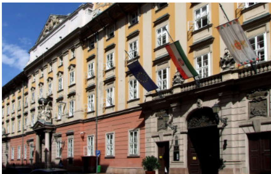
Képünkön a Fővárosi Önkormányzat épülete (forrás: budapestpont.hu)
